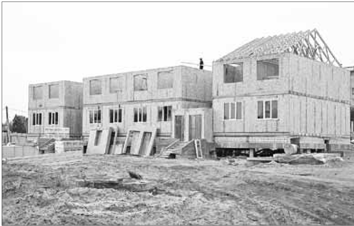
■ Строительство социальных домов на улице Конзихинской. ФОТО: ИВАН МАЛЫГИН
